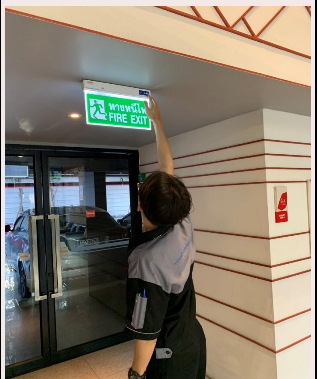
ภาคผนวกที่ 3.18 การตรวจสอบป้ายทางออกฉุกเฉิน
