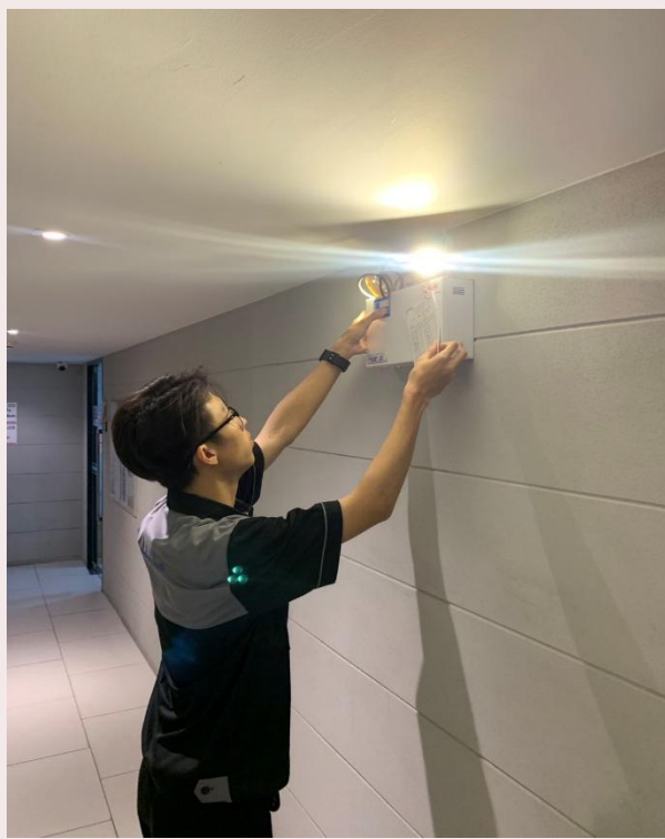
ภาคผนวกที่ 3.17 การตรวจสอบระบบไฟสำรอง
